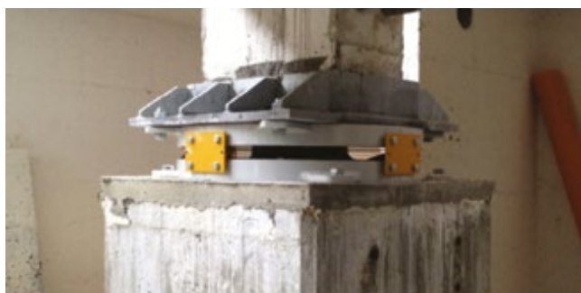
Inserimento di un isolatore a pendolo scorrevole in sommità di un pilastro, opportunamente ingrossato nella parte inferiore (foto FIP MEC)
